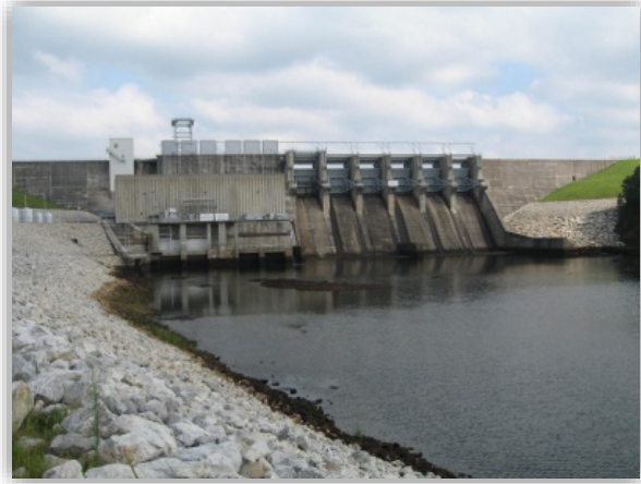
Figure 2-7 R. L. Harris Dam
